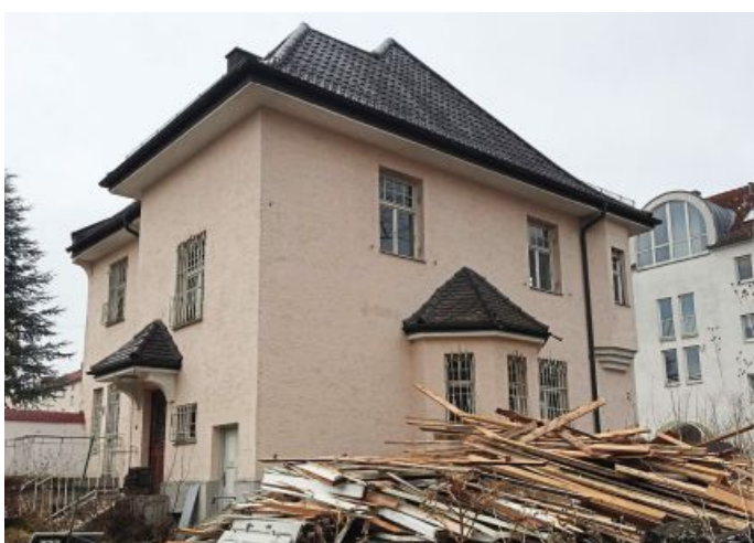
Trauriger Anblick: An der Fabrikantenvilla lagert Holzmüll.
