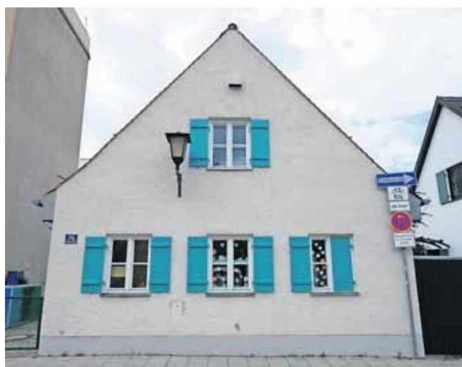
Raum für Eltern-Kind-Initiativen und andere Gruppen aus dem Viertel bietet das sanierte Kleinhaus in der Unteren Grasstraße 34.
