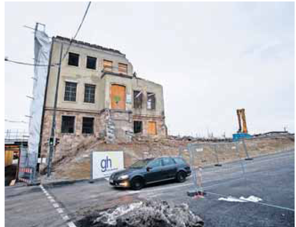
Der Abriss des Kopfbaus auf dem ehemaligen Stückgut-Gelände an der Landsberger Straße hat viele Pasinger schmerzlich getroffen.
