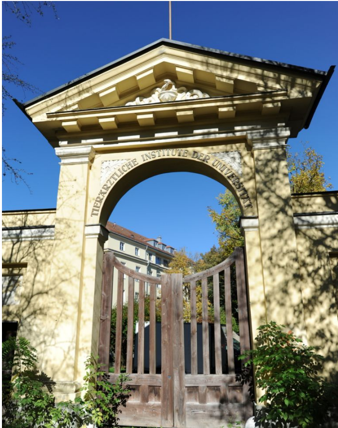
Bürger im Denkmaleinsatz: Die Münchner setzten sich vergeblich für den Erhalt der Kolberger-Villa und der Tierklinik-Gebäude ein. Foto: Stephan Rumpf
